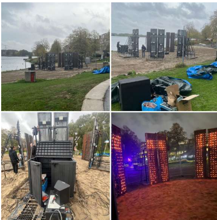
Bouwproces op het strand
